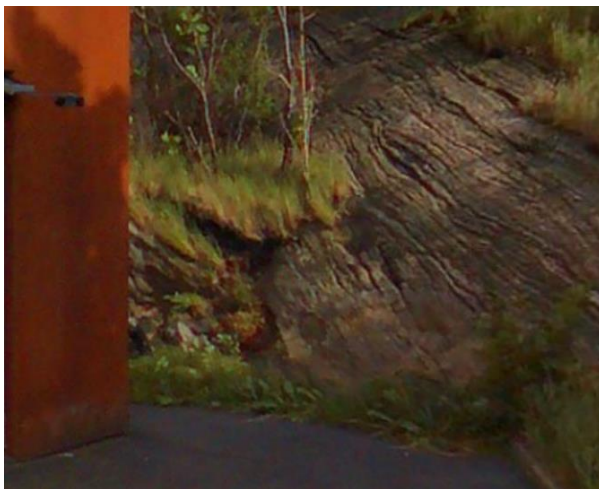
Figur 4. Den sydligaste delen av detaljplaneområdet där naturligt rundad håll övergår i sprängd skärning, ställvis skivuppsprucket berg.
